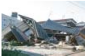
川口町中心部の家屋倒壊(04.10.28)
