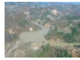
木箆集落25世帯中、14世帯が浸水した(04.12.16)
