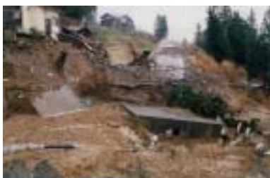
土砂崩れが家を飲み込んだ
