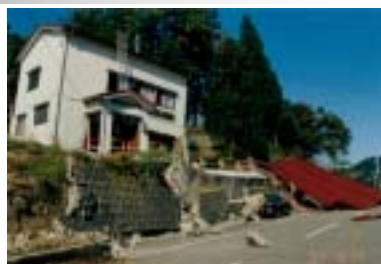
家屋とブロック擁壁の倒壊
