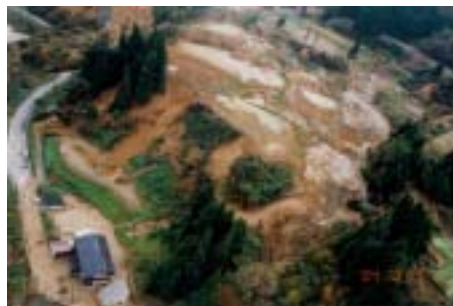
谷間にある民家へ土砂が崩壊
