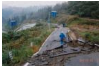
自動車の通行困難な箇所が至る所に存在
