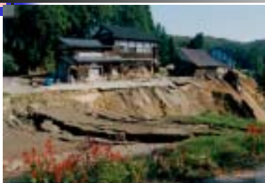
民家のすぐそばで土砂崩れが発生
